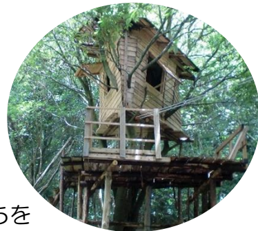
森の中に造られた ツリーハウス
