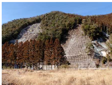
道路法面への転用
